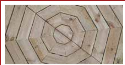
Standardgulv - er med i prisen! Trykimprægneret gulv, der er lagt i mønster efter pavillonens form
