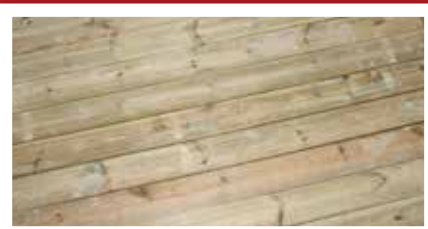
Lige gulv Gulvet er trykimprægneret og udført med brædder på langs
